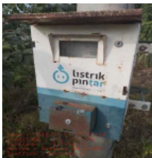
PENGECEKAN BOX KWH & KUNCI
